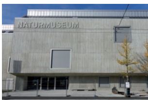
Naturmuseum, St.Gallen – 2016 Rorschacherstrasse 263, St.Gallen Architektur: Armon Semadeni Architekten und Meier Hug Architekten, Zürich Auftrag: Hochbauamt Stadt St.Gallen
