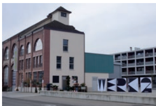
Zwischennutzung Werk2, Arbon – 2024 Webstrasse, Saurer Areal, Arbon Architektur: Schmidlin Architekten, Zürich Auftrag: Hochbauamt Kanton Thurgau
