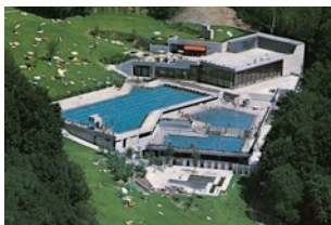
Sanierung Hallen- und Gartenbad, Obersiggenthal Schwimmbadweg 1, Nussbaumen Architektur: Roger Zeier Bauökonomie, Ennetbaden Auftrag: Gemeinde Obersiggenthal
