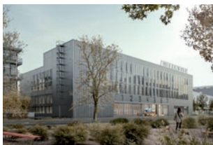
Wache Nord, Zürich Oerlikon Binzmühlestrasse, Zürich Oerlikon Architektur: Enzmann Fischer Architekten, Zürich Auftrag: Enzmann Fischer Architekten, Zürich
