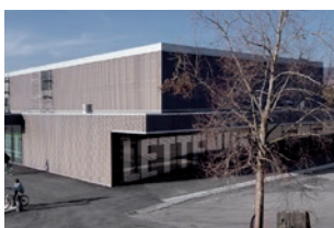
Sporthalle Letten, Diessenhofen – 2011 Alte Basadingerstrasse 10, Diessenhofen Architektur: Graf Biscioni Architekten, Winterthur Auftrag: Stadtgemeinde Diessenhofen
