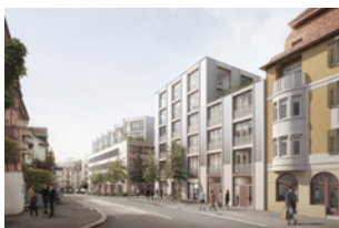
Arealüberbauung Park Neumünster, Zürich Flurstrasse 130, Zürich Architektur: Armon Semadeni Architekten, Zürich Auftrag: SwissRe Investments AG, Zürich
