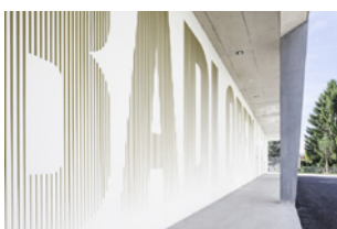
Schwimmbad Oberwinterthur – 2012 Mooswiesenweg 44, Winterthur Architektur: Walser Zumbrunn Wäckerli, Winterthur Auftrag: Stadt Winterthur
