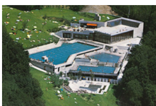
Sanierung Hallen- und Gartenbad, Obersiggenthal Schwimmbadweg 1, Nussbaumen Architektur: Roger Zeier Bauökonomie, Ennetbaden Auftrag: Gemeinde Obersiggenthal
