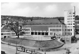
Gesamtinstandsetzung und Neunutzung Kirchgemeindehaus Wipkingen, Zürich Rosengartenstrasse 1, Zürich Architektur: Conen Sigl Architekt:n:nen, Zürich Auftrag: Evangelisch-reformierte Kirchgemeinde Zürich
