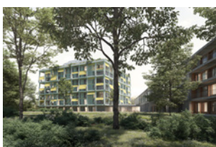
Ersatzneubau Gesundheitszentrum Bachwiesen, Zürich Flurstrasse 130, Zürich Architektur: Piertzovani Toews, Basel Auftrag: Piertzovani Toews, Basel
