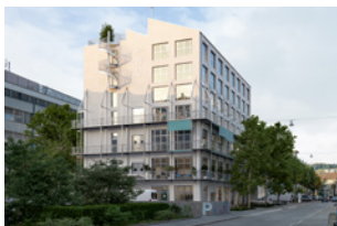
Gewerbehaus Flüelastrasse, Zürich Flüelastrasse 16, Zürich Architektur: BS + EMI Architektenpartner, Zürich Auftrag: Stiftung PWG, Zürich
